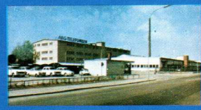
Plant at Ingolstadt
