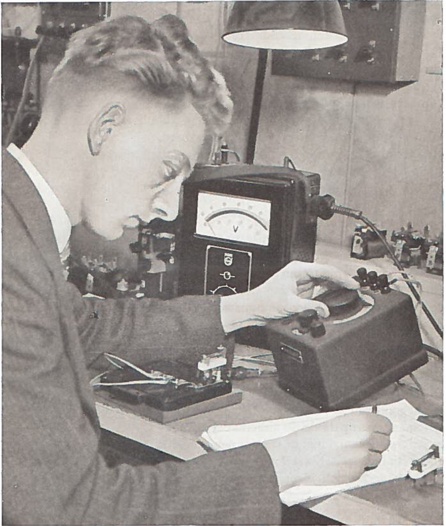
Fig. 5. Zelfinductiemetingen aan relais met behulp van de „Philoscop”. Op den achtergrond de Thermionische Voltmeter GM 4132.
