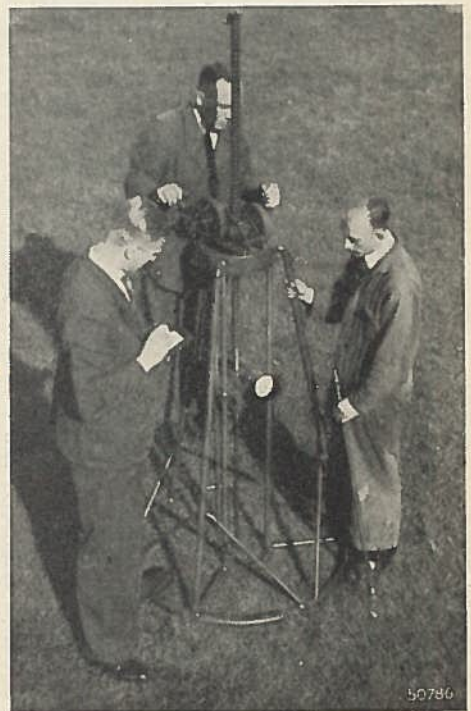
Fig. 2. Apparaat waarmee op regelmatige diepten de weerstand registreert, die bij het indringen in de bodem wordt ondervonden door een staaf welke aan het ondereinde is voorzien van een conus.
