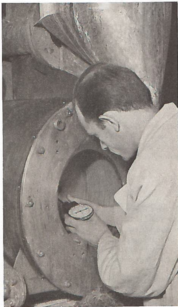
Fig. 3. Het bepalen van het toerental met behulp van een tachometer.
